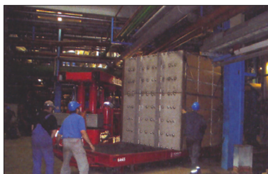
شکل ۱۲: کار میلی‌متری در هنگام جاگذاری بسته‌صفحه‌ای دومی زیر بدنه
