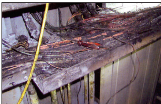
شکل ۸: کابل‌های سوخته شده، کارخانه واربورگ
