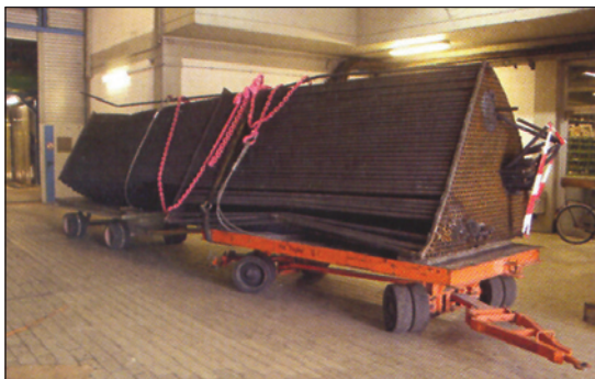
شکل ۹: بسته لوله‌های خارج شده از بدنه اول، کارخانه افن‌ناو
