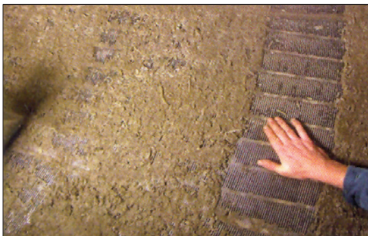
شکل ۶: توری دیفوزیون قبل از تمیز کردن
